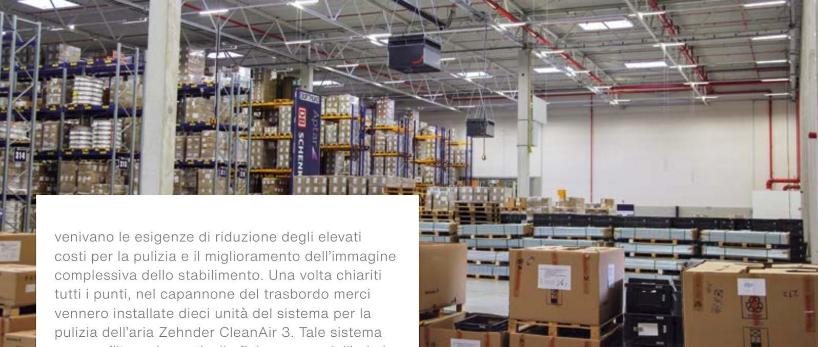
venivano le esigenze di riduzione degli elevati costi per la pulizia e il miglioramento dell'immagine complessiva dello stabilimento. Una volta chiariti tutti i punti, nel capannone del trasbordo merci vennero installate dieci unità del sistema per la pulizia dell'aria Zehnder CleanAir 3. Tale sistema serve a filtrare le particelle fini e grosse dall'aria in circolazione prima che si depositino danneggiando persone, merci o macchinari.
