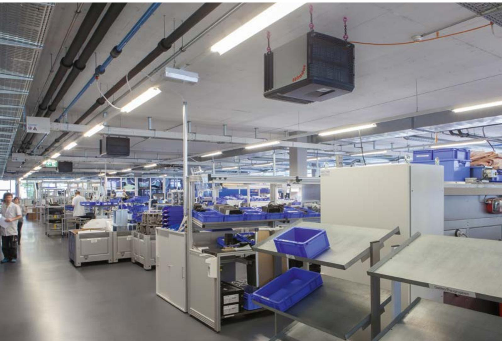
final. Elles y fonctionnent en continu, de façon automatique, avec deux niveaux de puissance réglables et programmables grâce à une minuterie. De cette manière, Hamilton Medical peut régler le temps de fonctionnement individuellement et en toute flexibilité, sans pertes de charge ni réduction des performances.
