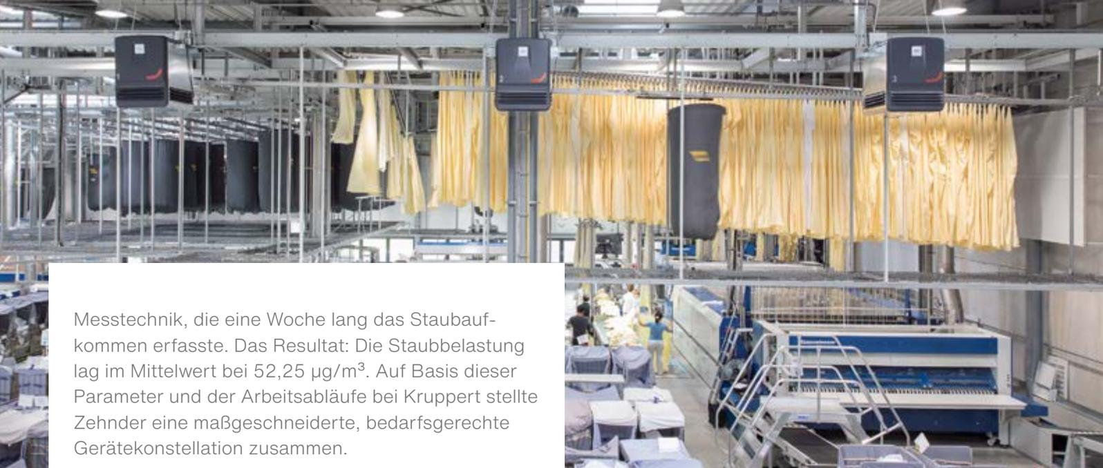
Messtechnik, die eine Woche lang das Staubaufkommen erfasste. Das Resultat: Die Staubbelastung lag im Mittelwert bei  $52,25 \mu\text{g}/\text{m}^3$ . Auf Basis dieser Parameter und der Arbeitsabläufe bei Kruppert stellte Zehnder eine maßgeschneiderte, bedarfsgerechte Gerätekonstellation zusammen.
